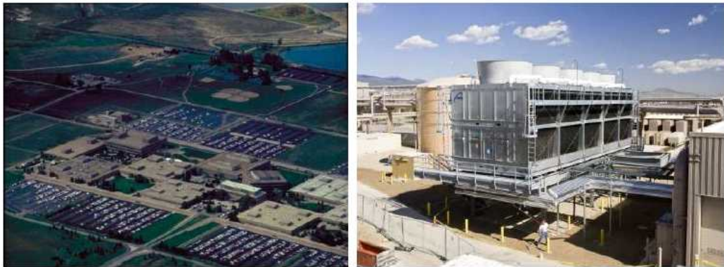
<그림 35> IBM 데이터 센터(볼더)의 전경(왼쪽) 및 워터 이코너마이저용 냉각 타워(오른쪽)
