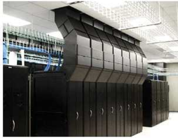
<그림 12> Chimney Rack
