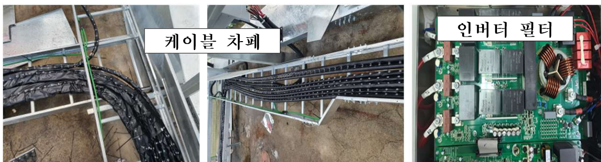
[그림 4-2] 케이블 차폐 및 인버터 필터
