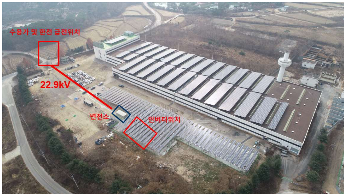
[그림 2-3] 스위트캐슬 태양광 발전설비 전면도
