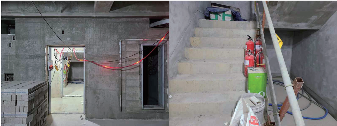
[그림 5] 공사현장 조명설비와 소방설비 설치 현황
