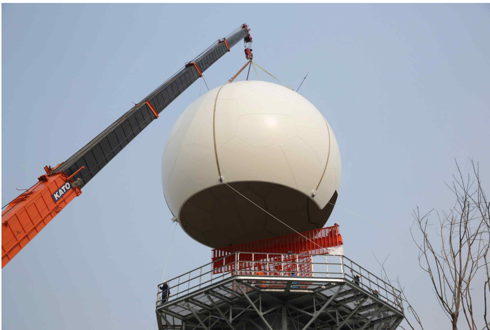
그림 14. S-대역 1차 감시레이다 (PSR, 인천국제공항)
