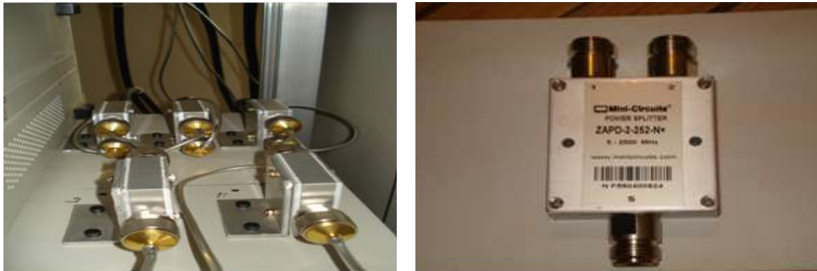
[그림 34] 신호분배기 설치
