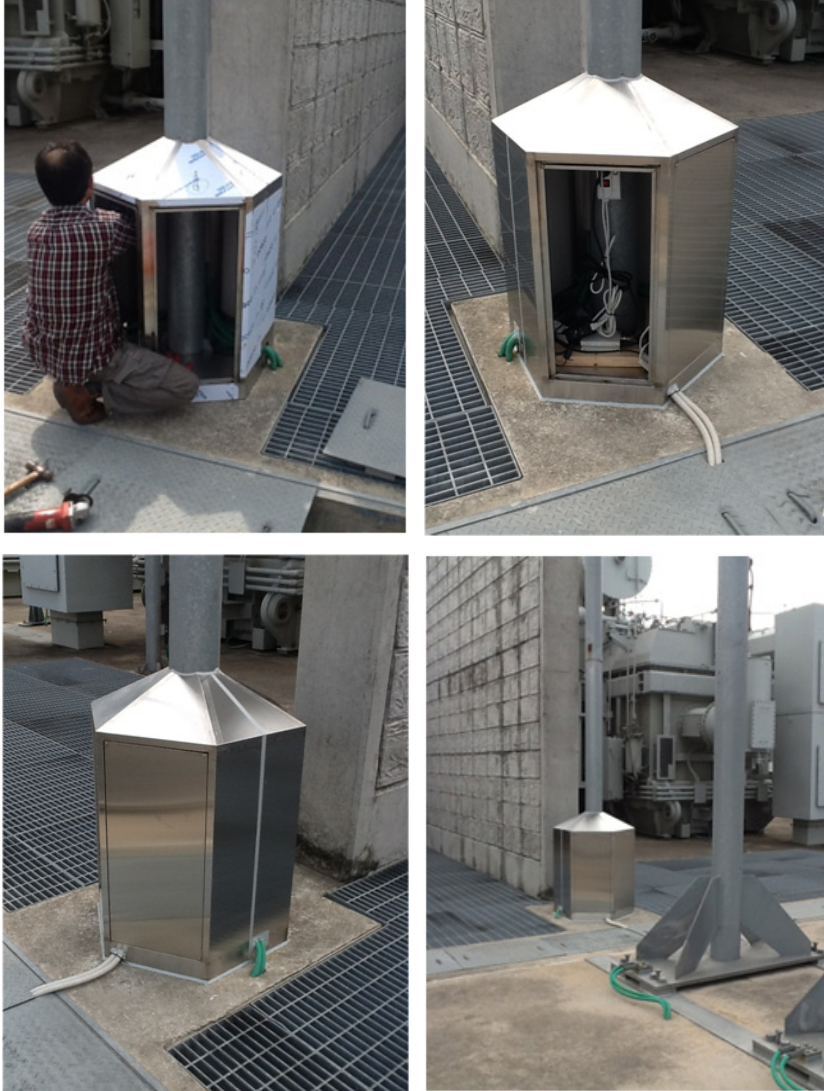
[그림 51] 신가평 변전소 지자기 유도전류 측정기 설치
