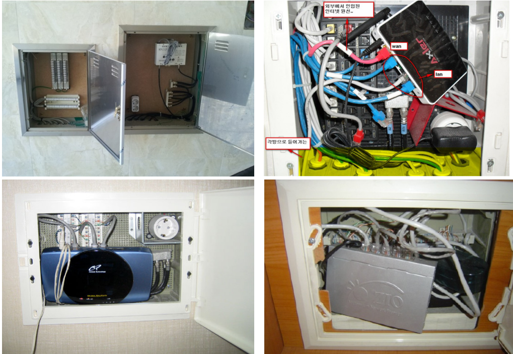
[그림 2-1] 작은 단자함에 설치된 초고속 장비들
